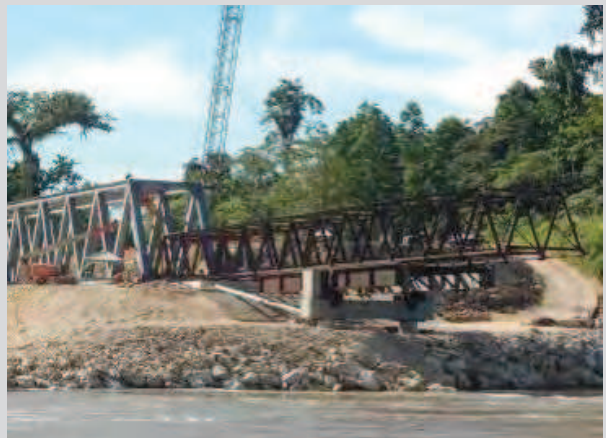
Exxon PNG LNG – Bridge Launch
