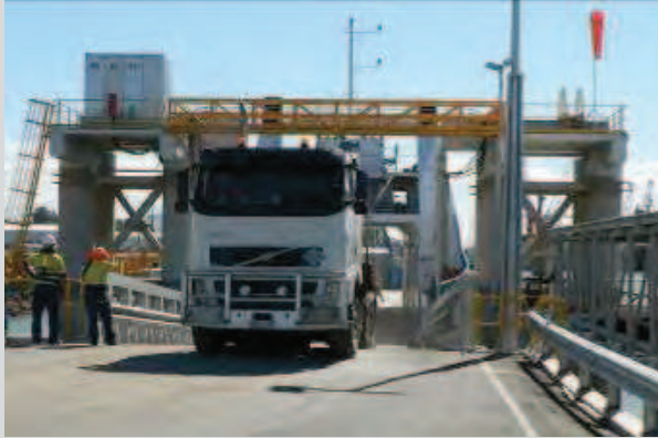
GLNG – RoRo Linkspan
